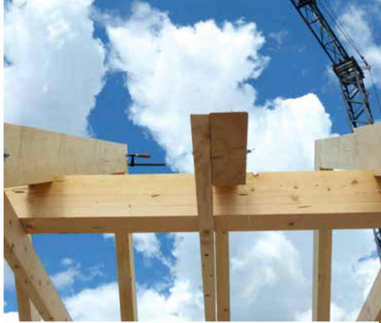
Ein Dachstuhl entsteht: Moderner Holzbau mit dem Naturbaustoff Fichte Leimholz SI
