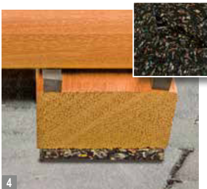
4 Gummi reguliert: Höhenausgleich-Pads für die Unterkonstruktion.
