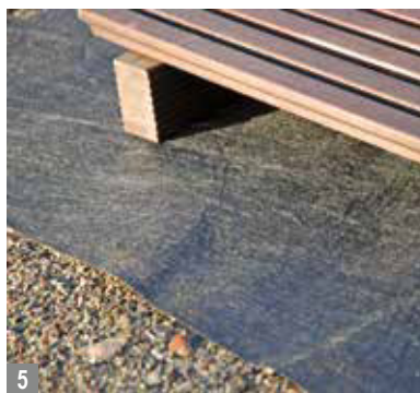
5 Wasserdurchlässiges Abdeckvlies gegen Durchwurzelung und Pfützenbildung.
